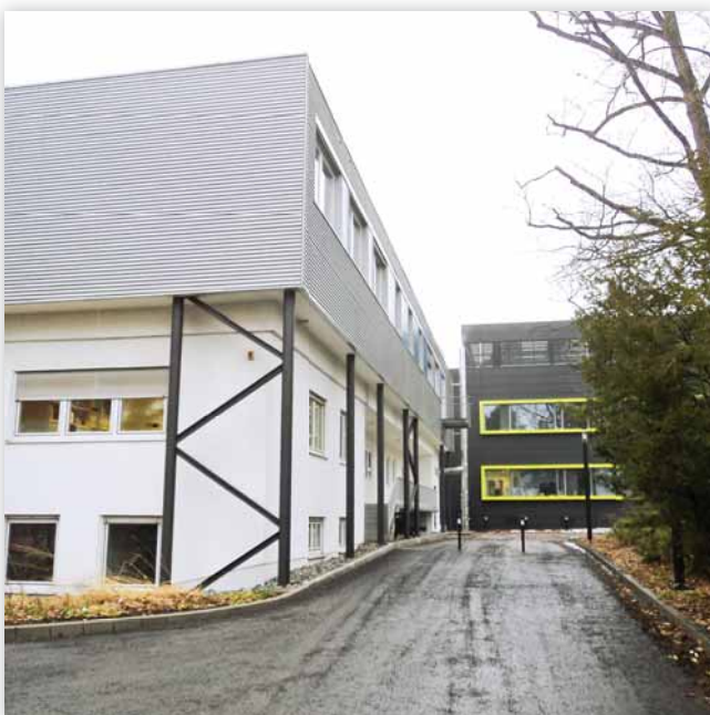
Außenansicht Bio-Forschungszentrum, Erlangen
