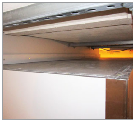
Stufenweise Umbauung eines Lüftungskanals
