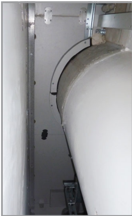
Deckenanpassung an runde Säule
