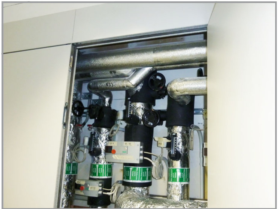
Verschließbarer Brand- und Rauchschutz mit nur 42 mm Stärke
