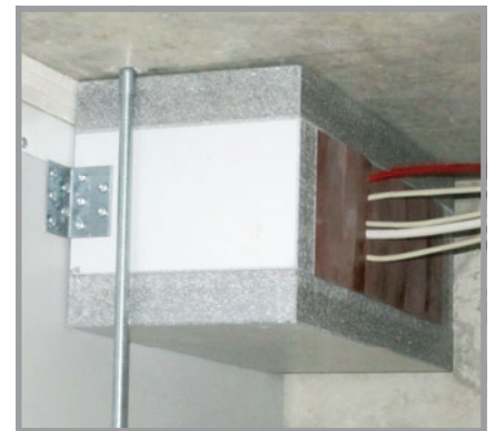
Kombischott für Elektrokabel von PRIORIT
