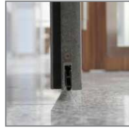
■ Rauchschutzdichtung (RS) am Boden; alternativ: umlaufende Zarge
