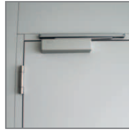
■ Selbstschließende Tür(en)
