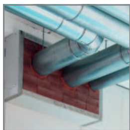
■ Rohr- und Kabelschott
