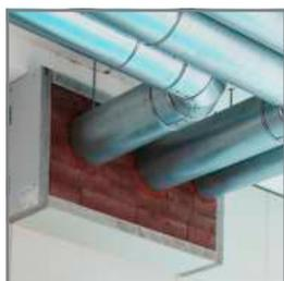
■ Rohr- und Kabelschott
