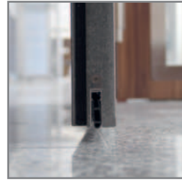
■ Rauchschutzdichtung (RS) am Boden; alternativ: umlaufende Zarge
