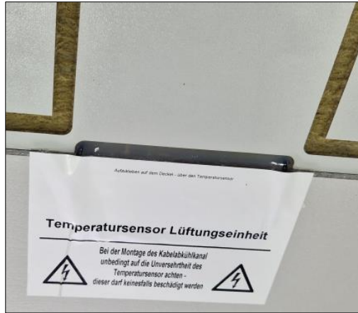
Abbildung 20, Versiegelung Temperatursensor Deckenelement
