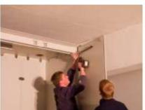
• Türschließer und Gleitschienen nach Herstelleranleitung montieren. Vorbohrungen sind vorhanden.
