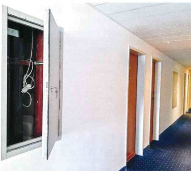
Revisionsöffnungsverschluss mit einer Feuerwiderstandsfähigkeit über 90 min, flächenbündig eingebaut.
