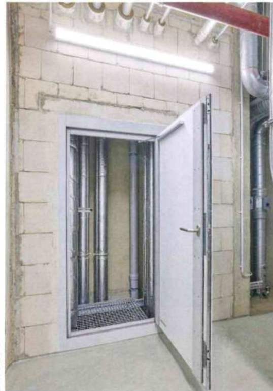
Revisionsöffnungsverschluss entsprechend den Anforderungen der Muster-Hochhaus-Richtlinie mit (innen liegendem) Obentürschließer.
