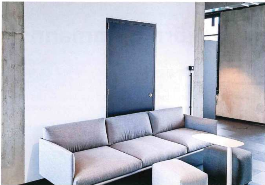
Revisionsöffnungsverschluss mit Sonderdekoroberfläche passend zu dem bestehenden Farbkonzept.
