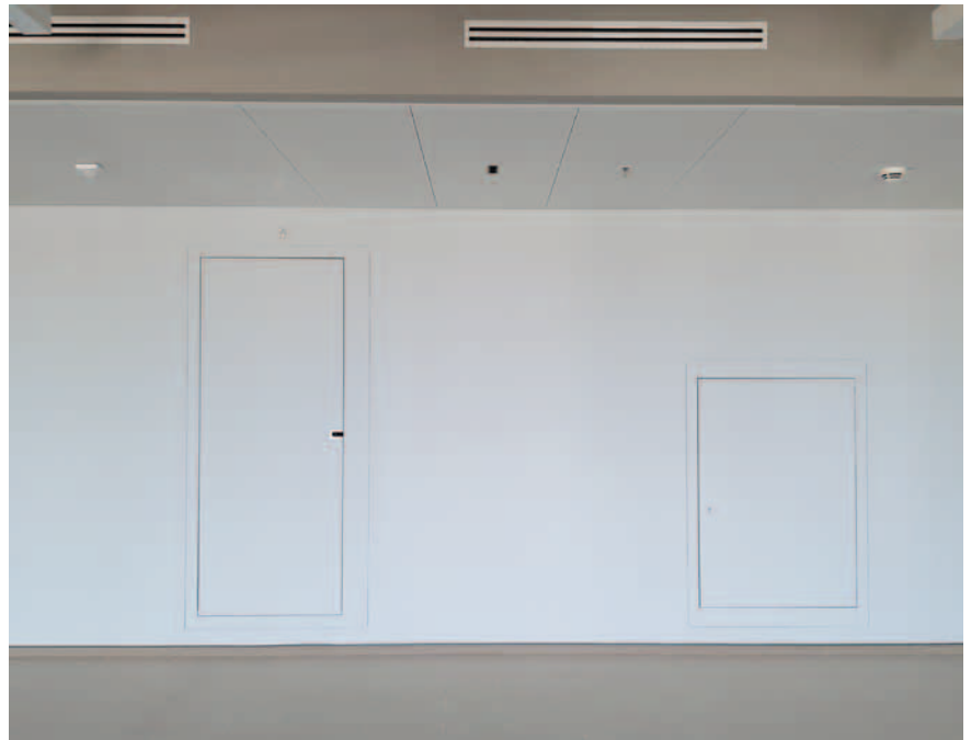
Entrauchungsklappe PRIODOOR ETX RDA und Revisionsöffnungsverschluss PRIODOOR RTH nebeneinander angeordnet. Dezent und unauffällig bei Einhaltung aller funktionalen und sicherheitstechnischen Anforderungen
