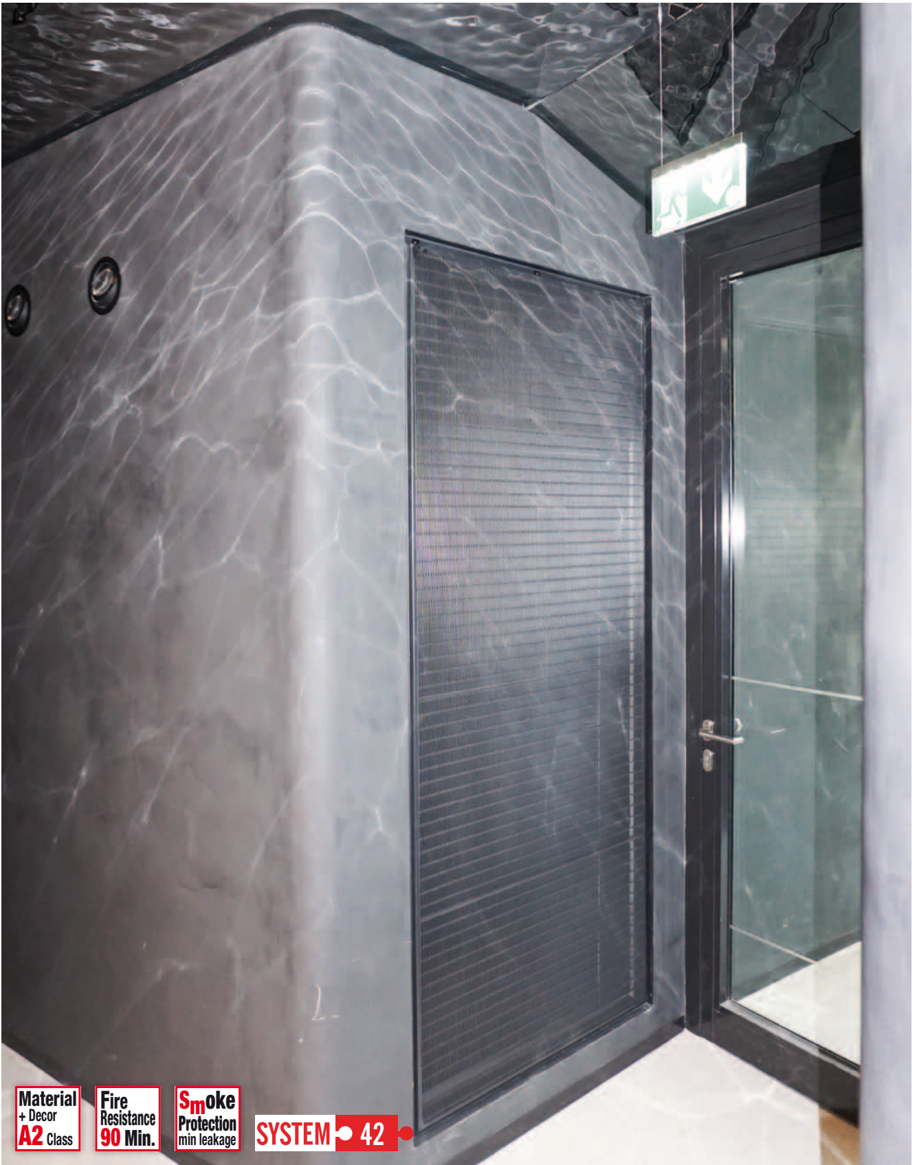
Entrauchungsklappe PRIODOOR ETX RDA mit vorgesetztem Schutzgitter
