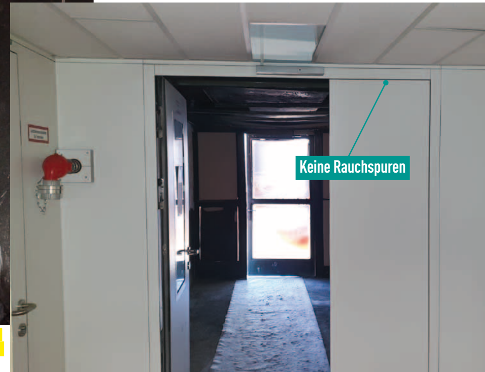
WIE NEU! NACH dem Brand auf der dem Brand abgewandten Seite: PRIORIT System 42 – Wandbausystem mit Feuerschutztüre. Keinerlei Durchlass von Feuer oder Rauch zu dem Stichflur.
