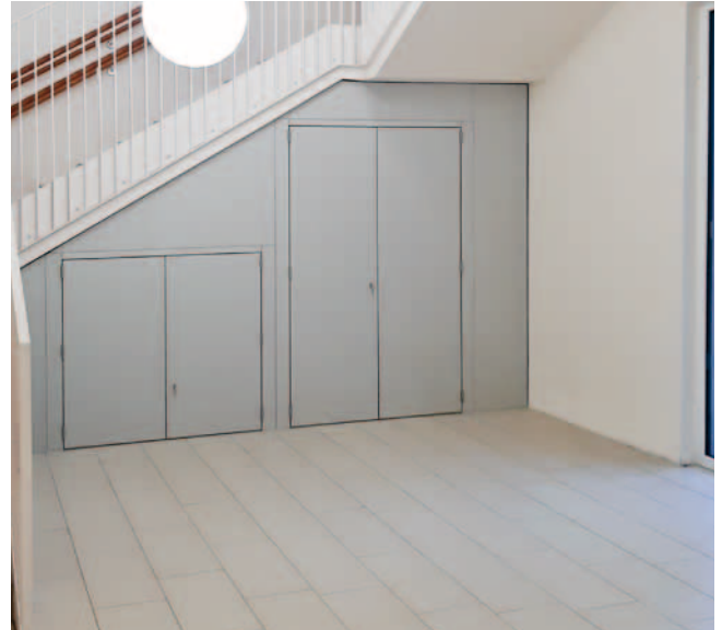
Nach der Sanierung – Wandsystem PRIOWALL mit großformatigen Revisionsabschlüssen
