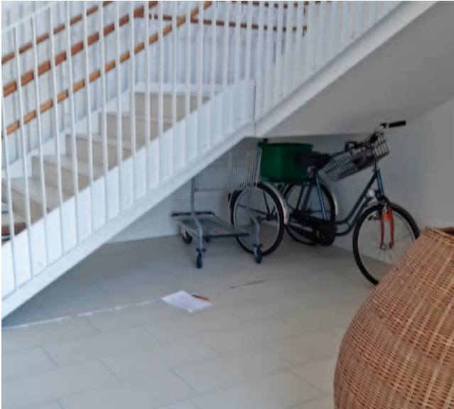
Vor der Sanierung – Freie Fläche im Treppenhaus
