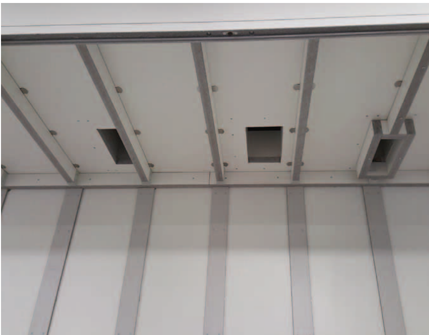
Vorbereitete Aussparungen für die noch zu montierenden Kabelschotts
