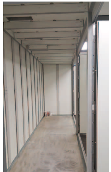
Verspachtelter Fliesenboden im Innenbereich
