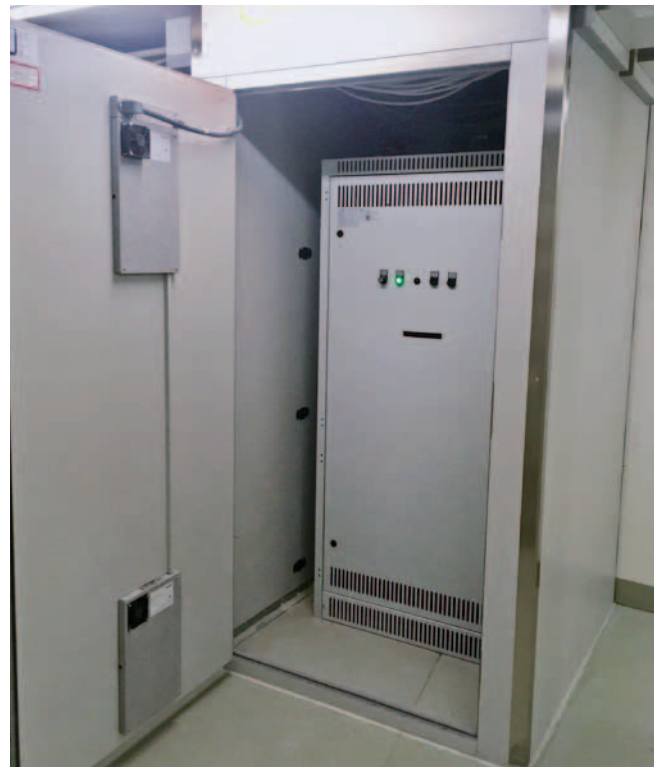
Belüftungsöffnungen im Revisionsabschluss
