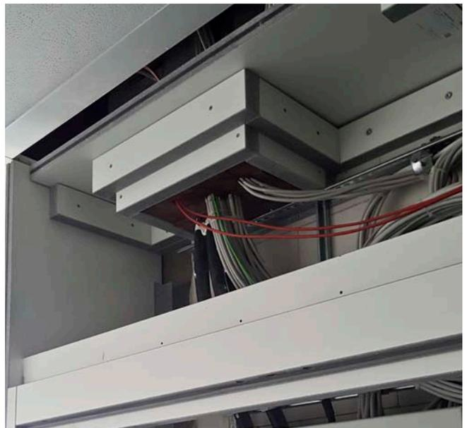
Detailbild: Einhausung mit Decke und Kabelschotts
