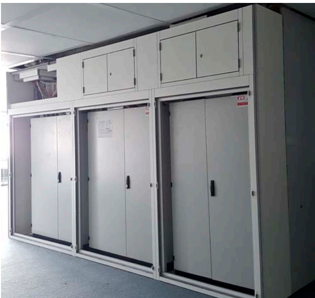
Während der Baumaßnahme
