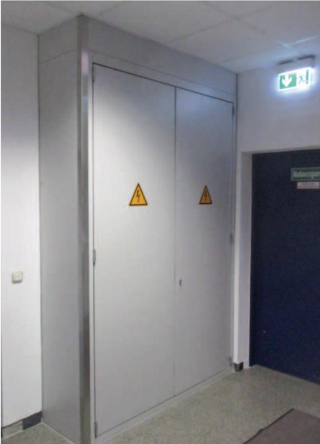
Die großformatigen Revisionsabschlüsse stellen eine komfortable Zugänglichkeit der Installationen sicher
