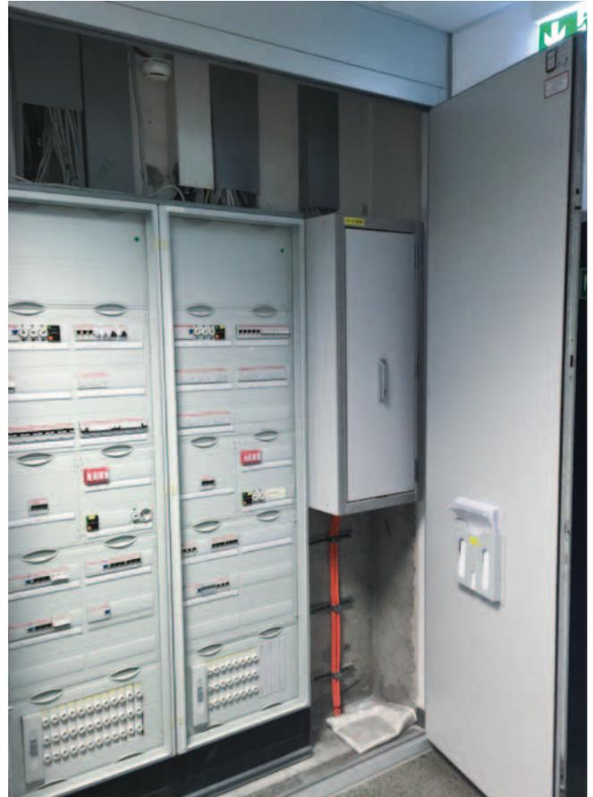
Feuerbeständige Abschottung von Installationen und Verteilern - optimal zugänglich und optisch ansprechend
