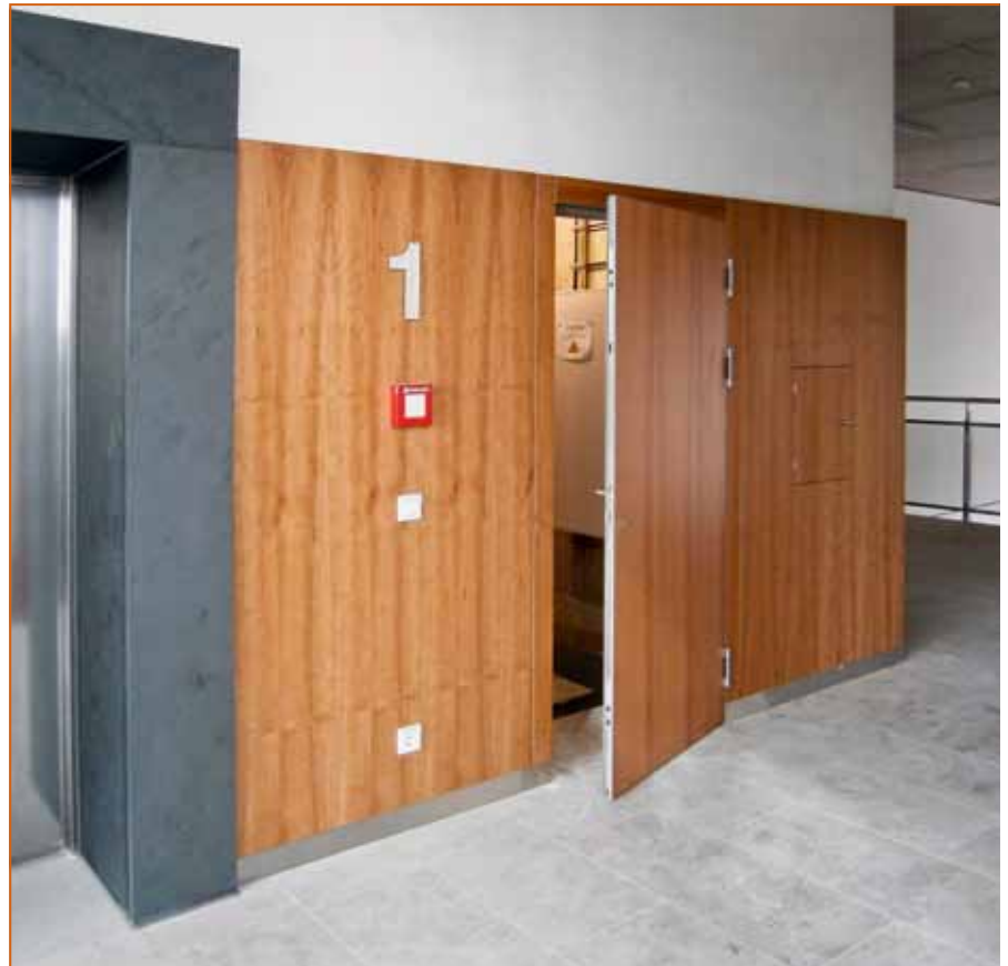
Abb. 3: Großformatiger Revisionsöffnungsabschluss: flächenbündig verbaut, EI 90, nichtbrennbar A2-s1, d0, rauchdicht durch absenkbare Bodendichtung
